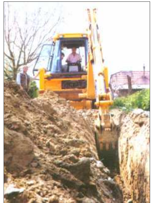
Slika 28. Izgradnja plinskih instalacija
